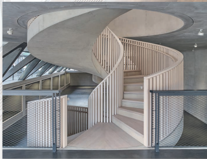
Kreisbogentreppe im Zentrum eines Verwaltungsgebäudes der SBB. Um einen tragenden Betonkörper wurde eine filigrane Holztreppe gebaut.
